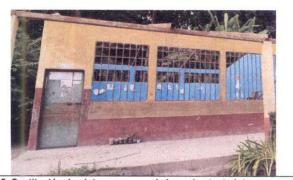
Foto 5: Sustitución de pintura en muro de las aulas tanto interno como externo
