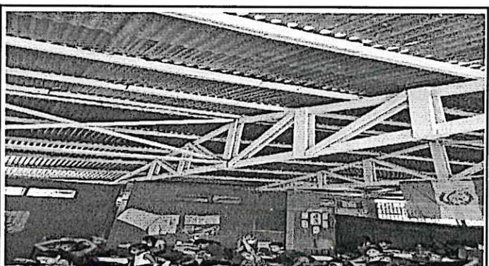
Sustitución de cubierta de lámina por lámina troquelada calibre 26 y sustitución de estructura de soporte de madera por metal
