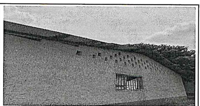
Sustitución de cubierta de lámina por lámina troquelada calibre 26 y sustitución de estructura de soporte de madera por metal
