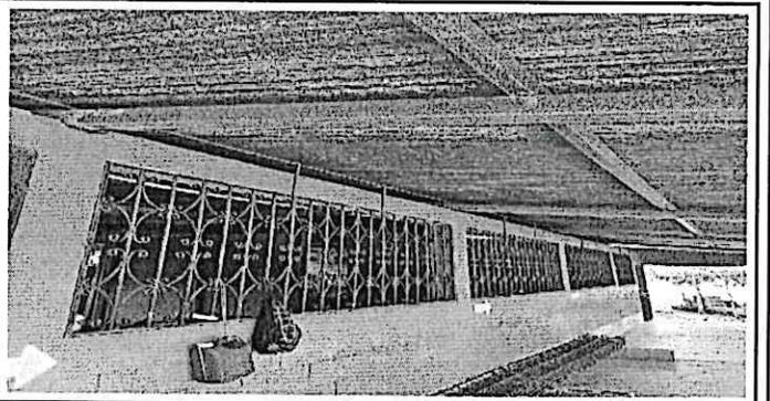
Sustitución de cubierta de lámina y mantenimiento de estructura de soporte de metal, sustitución de piso de baldosa de concreto
