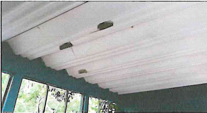
Foto 1: Sustitución de lámina por láminas troqueladas de aluzinc nuevas.
