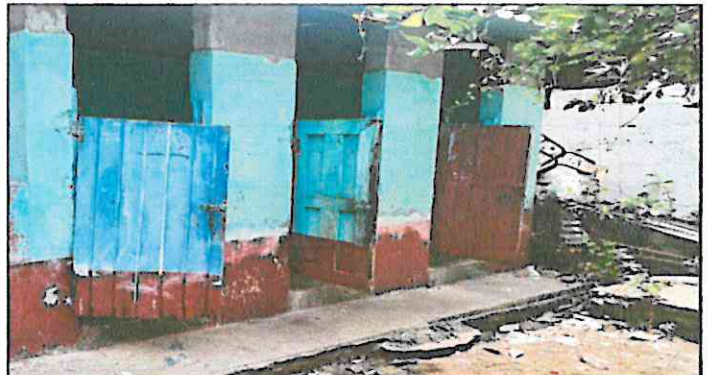
Foto 4: 3 Puertas deteriorados por el tiempo y uso de baños, se necesita cambio total.
