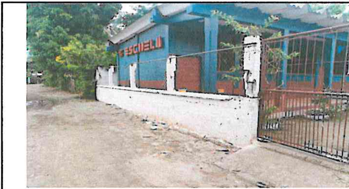
Foto 3: Mantenimiento de muro perimetral.
