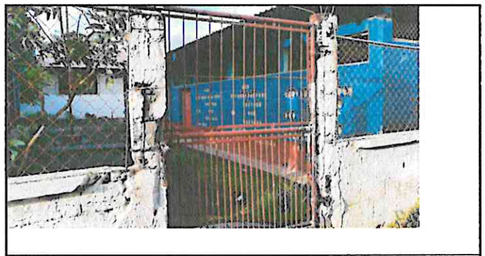
Foto 6: Mantenimientos de portones
