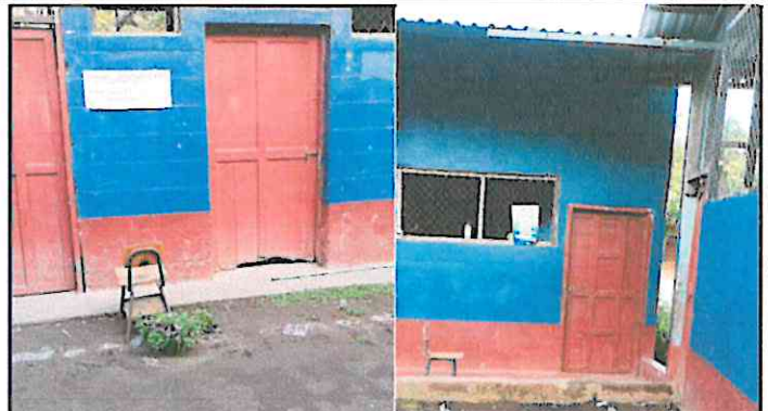
Foto 2: Instalación de puertas de metal en 4 módulos de aulas
