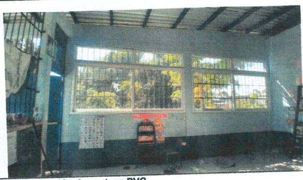
Foto 5: Instalación de ventana PVC
