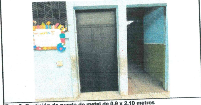
Foto 2: Sustitución de puerta de metal de 0.9 x 2.10 metros
