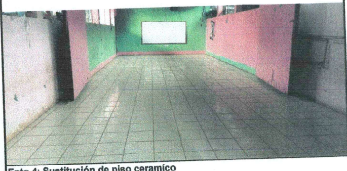
Foto 4: Sustitución de piso cerámico
