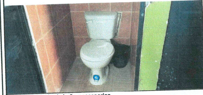
Foto 3: Instalación de baño y accesorios
