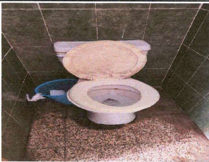
Foto 3: Sustitución de servicio sanitario y sus accesorios
