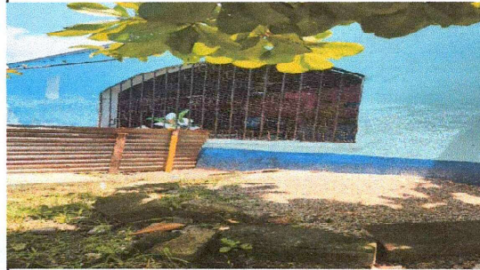
Foto 2: Instalación de ventanas de pvc
