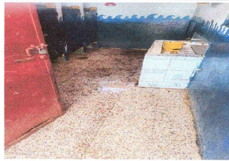
Foto 4: Sustitución de puertas
