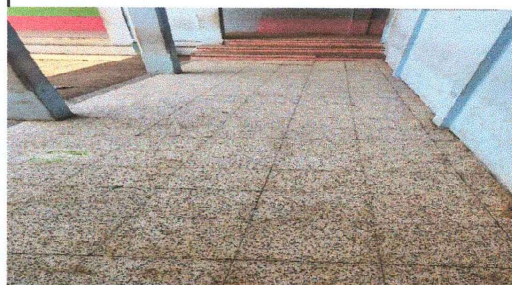
Foto 6: Sustitución de piso de granito por piso ceramico
