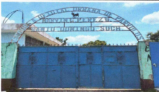
Foto 5: Reparación de porton
