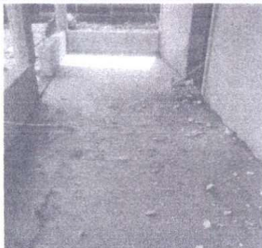
FOTO 3. Elaboración de torta de concreto.
