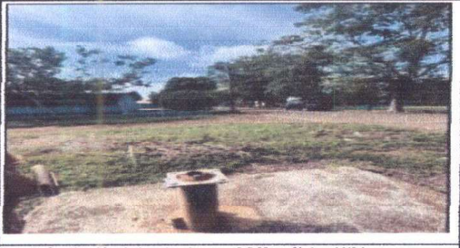
Foto 5: Sustitución de bomba de agua 0.5 Monofásico 11/2 hp
