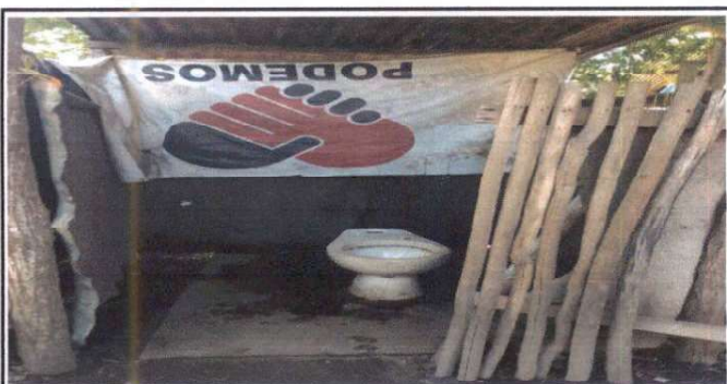
Foto 5: Sustitución de sanitario completo
