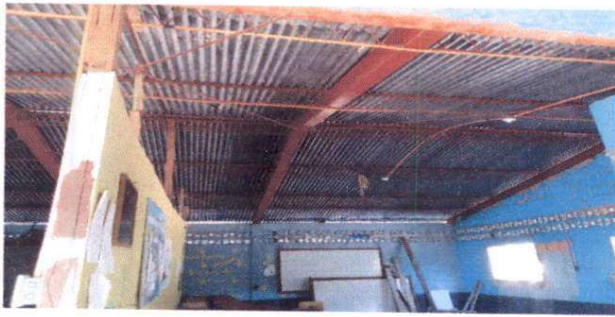
Foto1: Sustitución de sistema eléctrico
