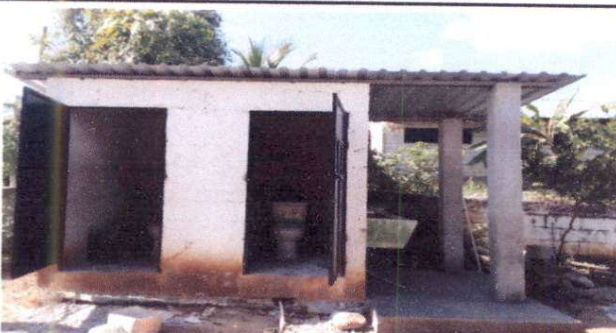
Foto 5: sustitución de cubierta de lámina y estructura de soporte de metal, mantenimiento de puertas , repello y cernido en paredes
