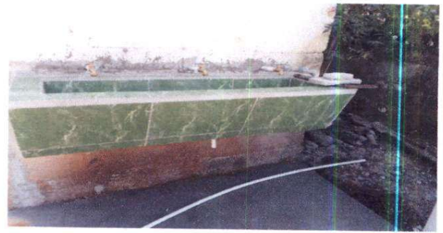
Foto 2: suministro de lavamanos de concreto
