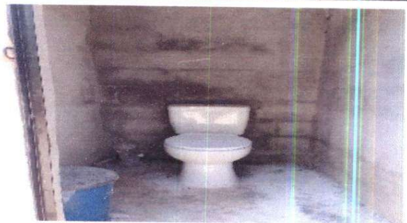
Foto 6: sustitución de inodoros
