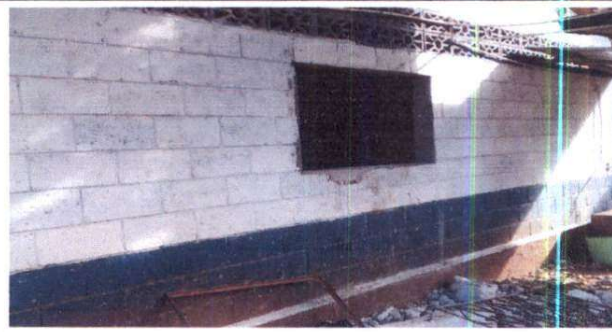
Foto 2: Ampliación de ventanas en modulo 1
