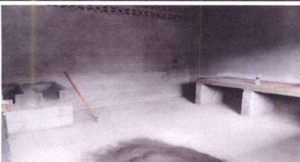
Foto 3: Se realiza estufa rural y gabinete de concreto
