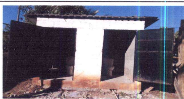
Foto 6: repello y cernido en paredes, inicio de sustitucion de inodoros
