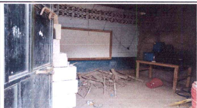
Foto 3: Reparación de área de cocina
