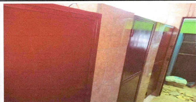
Foto 7: Fabricación e instalación de puertas de metal en modulo de servicios sanitarios
