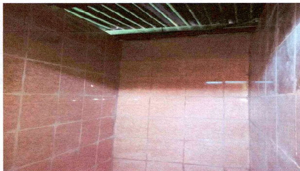
Foto 3: Instalación de azulejo en modulo de servicios sanitarios
