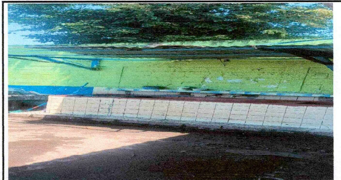
Foto 18: Repello en muro en modulo de pila
