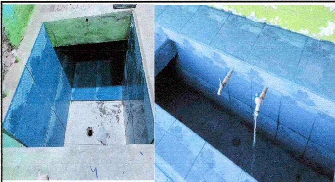
Foto 15: Sustitución de azulejos en pila en modulo de pila
