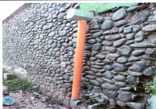
Foto 10: Sustitución de bajada pluvial, tubo PVC 4" en modulo de aula 1
