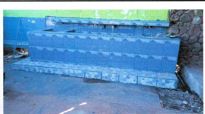
Foto 16: Sustitución de azulejos en pila en modulo de pila
