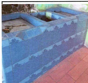
Foto 12: Sustitución de azulejo en modulo de cocina
