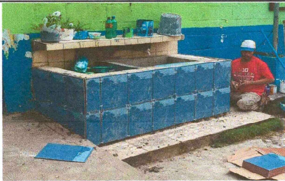
Foto 15: Sustitución de azulejos en pila en modulo de pila
