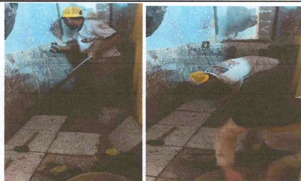
Foto 4: Sustitución de piso cerámico en modulo de servicios sanitarios
