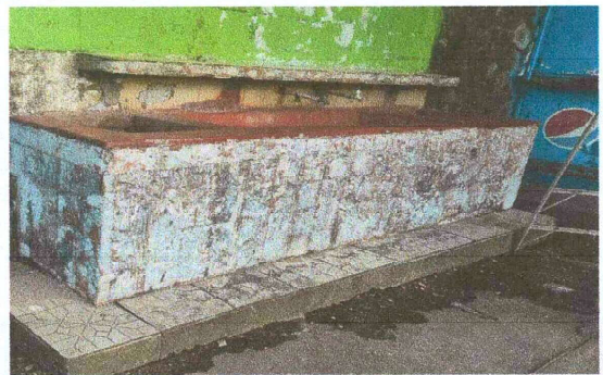
Foto 16: Sustitución de azulejos en pila en modulo de pila
