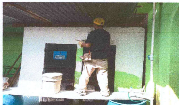
Foto 2: Repello en muro en modulo de servicios sanitarios
