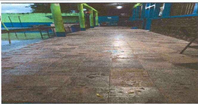
Foto 17: Sustitución de piso de granito por cerámico en modulo de 3
