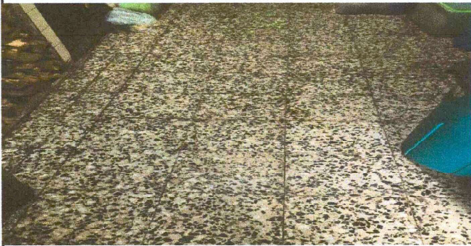
Foto 13: Sustitución de piso de granito por cerámico en modulo de cocina en modulo de cocina
