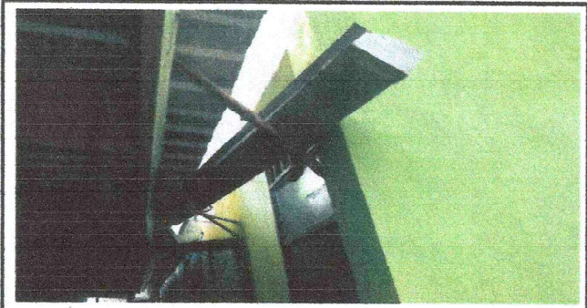
Foto 9: Sustitución de canal de metal en modulo de aula 4
