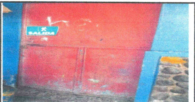
Foto 11: Sustitución de puerta de metal de modulo de cocina
