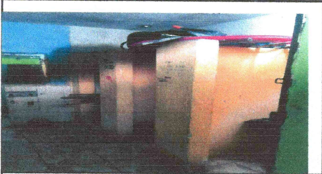
Foto 7: Fabricación e instalación de puertas de metal en modulo de servicios sanitarios
