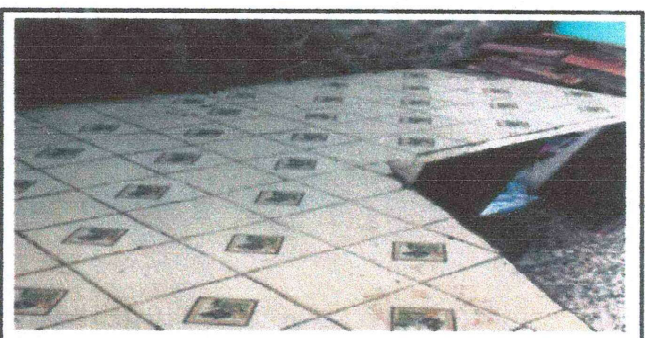
Foto 12: Sustitución de azulejo en modulo de cocina
