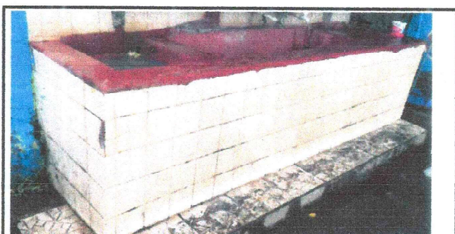
Foto 16: Sustrucción de azulejos en pila en modulo de pila
