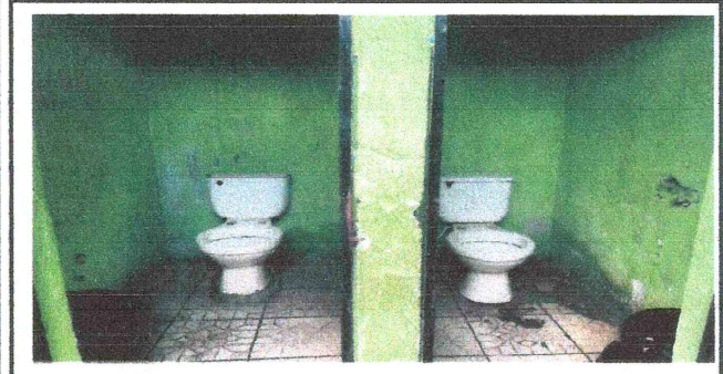
Foto 1: Sustitución de inodoros
