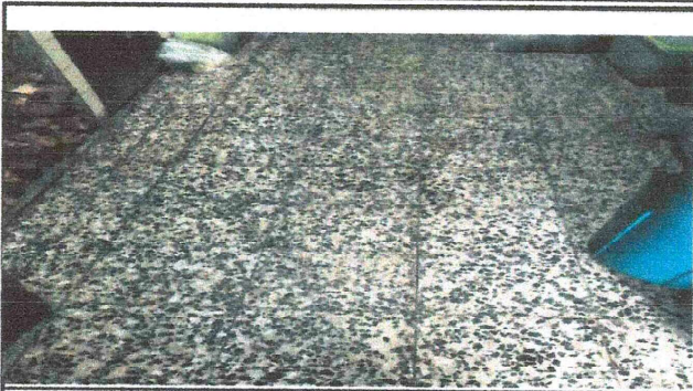
Foto 13: Sustrucción de piso de granito por cerámico en modulo de cocina en modulo de cocina
