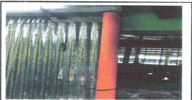
Foto 10: Sustitución de bajada pluvial, tubo PVC 4" en modulo de aula 1
