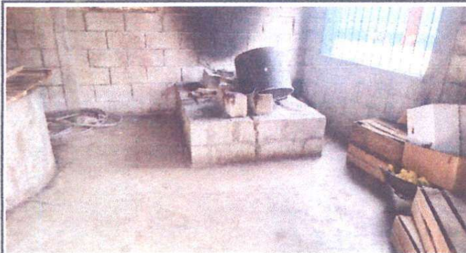
Foto 3: Sustitución de polleton a estufa rural (incluye) chimenea 2X1 y plancha de metal
