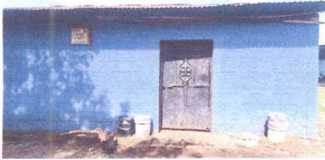
Foto 1: Mantenimiento a puertas de modulo de cocina 2.10 X 90
