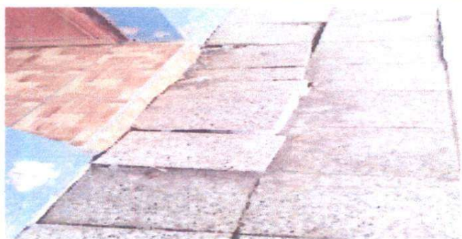
Foto 5: Sustitución de piso de granito, por piso ceramico
