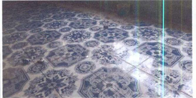
FOTO 2. Sustitución de piso de torta por piso cerámico.
