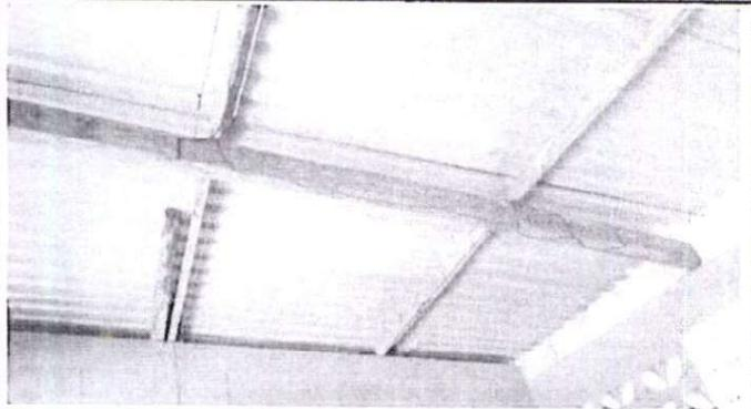
Foto 1: Sustitución de estructura de soporte de madera por metal (incluye bases de concreto para anclaje de columnas de metal)
