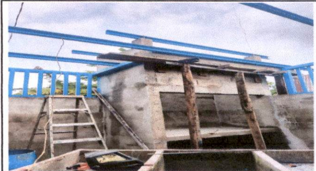
Construcción de poyetón
