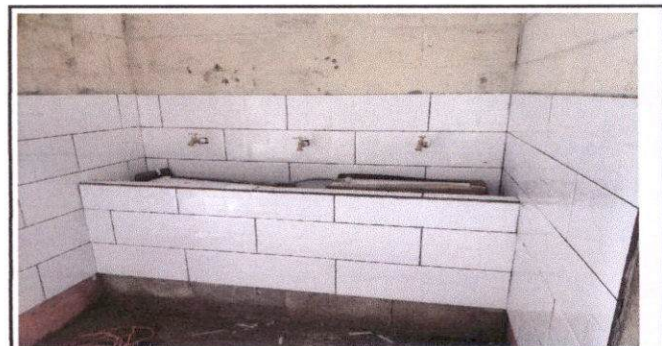
Sustitución de lavamanos
