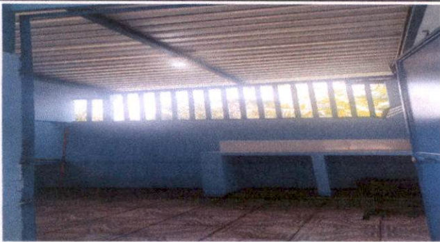
Reparación de Cocina
