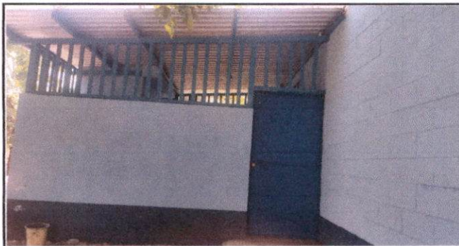
Reparación de puerta principal a cocina
