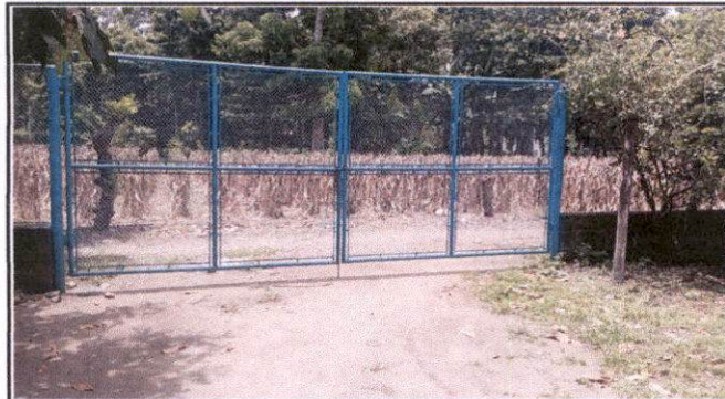
Sustitución de portón
