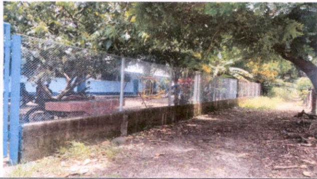
Reparación de muro perimetral con maya galvanizada, intermedios y columnas
