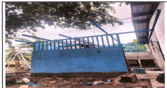
Reparación de cocina
