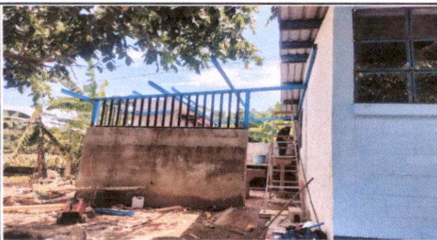
Sustitución de maya por balcones
