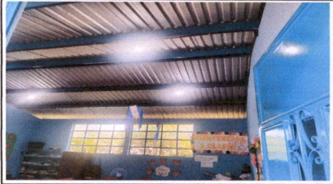
Sistema Electrico, cambio de lamparas
