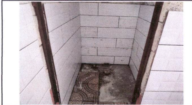
Sustitución de sanitario y sus accesorios
