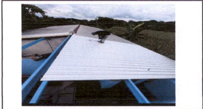
Sustitución de cubierta de lamina en el área de sanitarios
