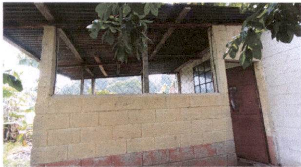
Reparación de cocina
