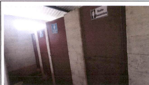
Sustitución de cubierta de lamina en el área de sanitarios
