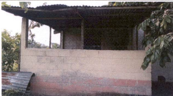
Sustitución de maya por balcones
