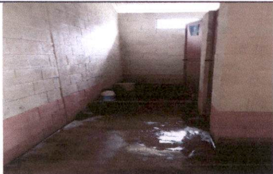
Reparación de baños
