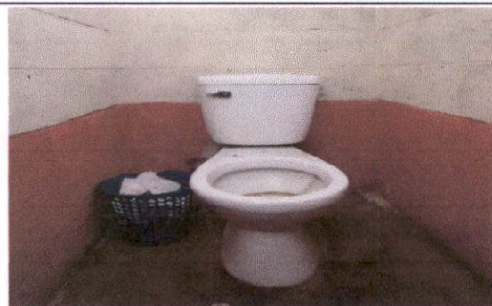
Sustitución de sanitario y sus accesorios
