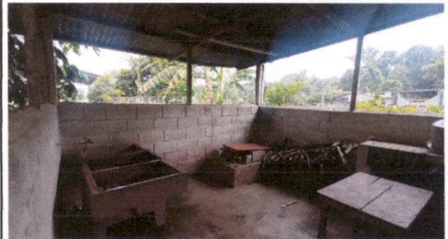
Construcción de poyetón
