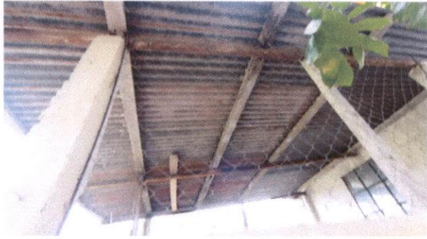
Sustitución de cubierta de láminas
