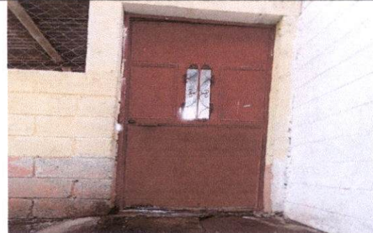
Reparación de puerta principal a cocina
