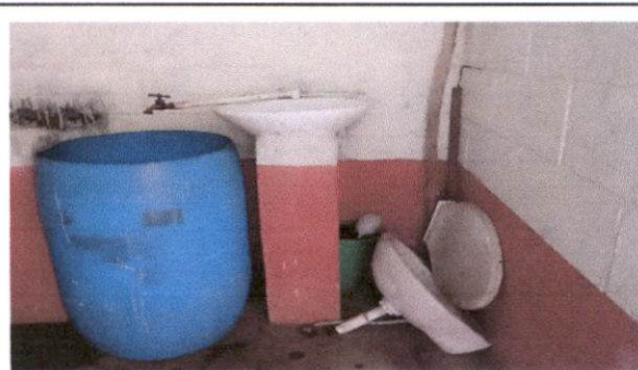
Sustitución de lavamanos
