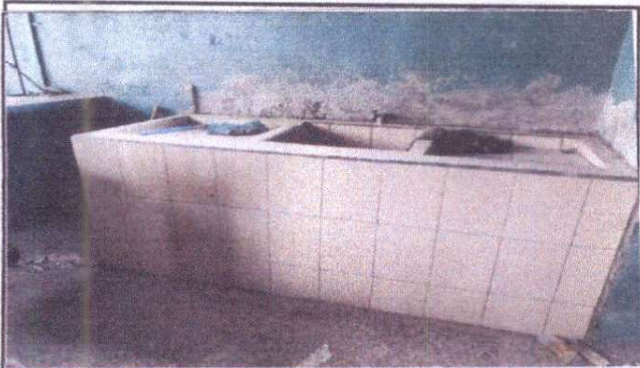
Foto 6: Pila artesanal de cocina ya terminada
