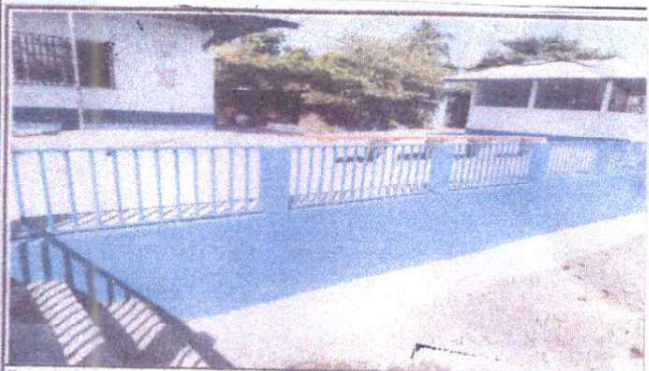
Foto 5: Baranda de seguridad terminado
