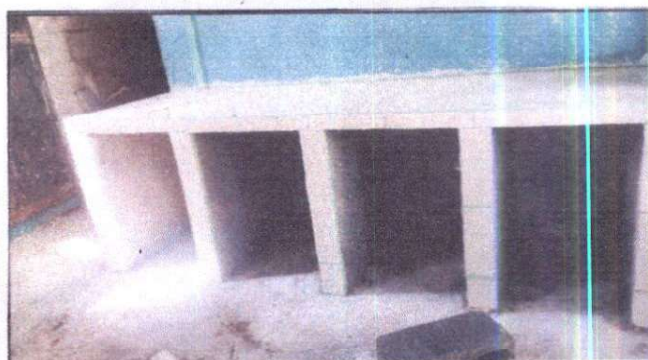
Foto 6: Mesa de trabajo de concreto de cocina en proceso
