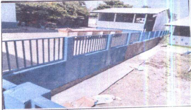
Foto 4: Barandal en proceso de pintura
