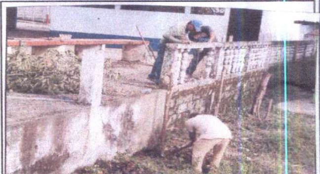
Foto 2: Baranda de seguridad en proceso de reconstrucción
