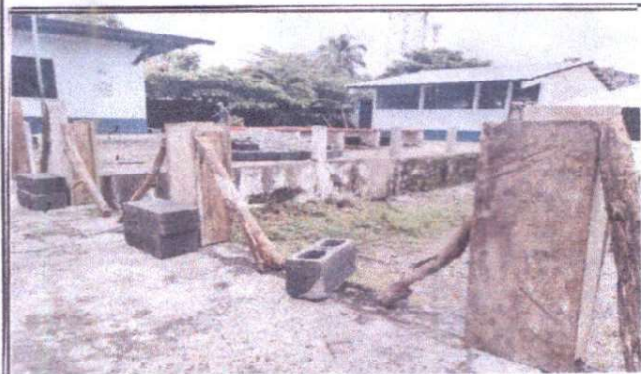
Foto 3: Fundición de columnas del barandal de seguridad
