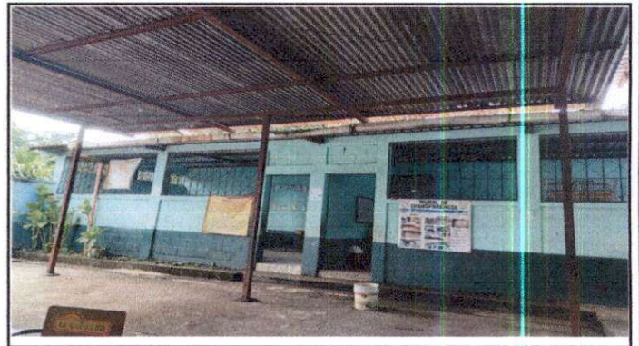
Foto 2: Columnas Galera Principal
