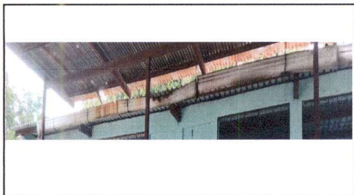
Foto 3: Canal de Agua Pluvial
