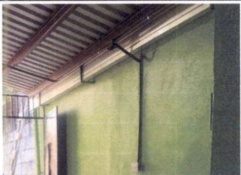
Foto 3:SUSTITUCIÓN DE CANAL DE CONCRETO POR METAL, FINALIZADO
