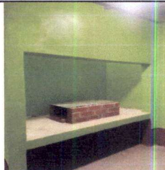
Foto 6: SUSTITUCIÓN DE CHIMENEA DE CONCRETO, FINALIZADO
