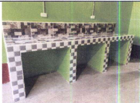
Foto 4:SUMINISTRO E INSTALACIÓN DE MESA PARA TRABAJO (DE CONCRETO Y AZULEJO) FINALIZADO
