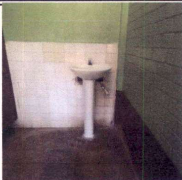
Foto1:SUSTITUCIÓN DE LAVAMANOS POR BATERÍA DE CONCRETO, FINALIZADO
