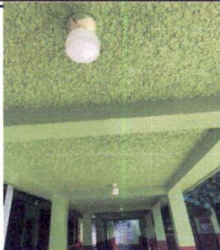
Foto 2: SUSTITUCIÓN DE LÁMPARAS FINALIZADO
