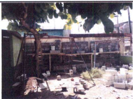
Foto 5: REPARACIÓN DE MURO PERIMETRAL DE BLOCK
