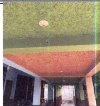
Foto 2: SUSTITUCIÓN DE LAMPARAS
