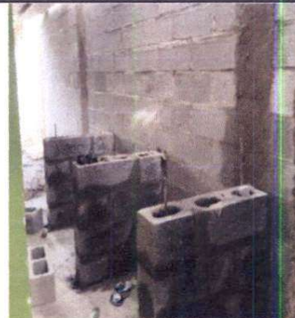
Foto 4: SUMINISTRO E INSTALACIÓN DE MESA PARA TRABAJO (DE CONCRETO Y AZULEJO)
