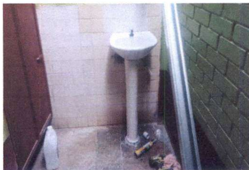
Foto1: SUSTITUCIÓN DE LAVAMANOS POR BATERÍA DE CONCRETO
