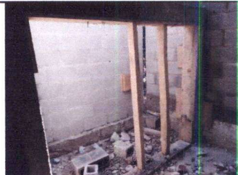
Foto 6: SUSTITUCIÓN DE CHIMENEA DE CONCRETO
