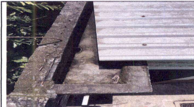
Foto 3: Sustitución de canal de concreto por metal
