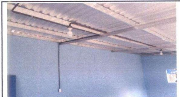
Foto 33: Sustitución de estructura de metal por metal y reparación de cableado eléctrico, lámparas, conectores y apagadores finalizado
