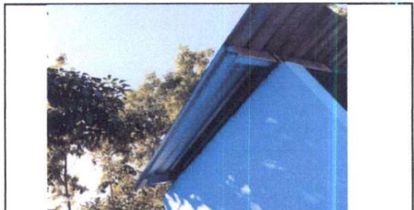
Foto 30: Sustitución de estructura de madera por metal y lámina por lámina troquelada calibre 26 finalizado
