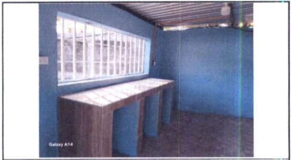
Foto 26: Sustitución de ventana de metal por ventana de metal y mueble de cocina de madera por concreto y azulejo finalizado
