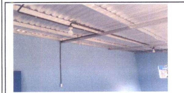
Foto 29: Sustitución de estructura de metal por metal y reparación de cableado eléctrico, lamparas, conectores y apagadores finalizado
