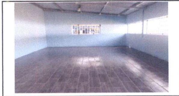
Foto 35: Sustitución de torta de cemento por piso cerámico finalizado
