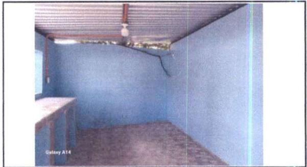
Foto 28: Suministro de repello, cernido e impermeabilización en paredes de cocina finalizado
