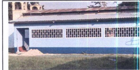
Foto 34: Sustitución de láminas troqueladas por láminas troqueladas calibre 26 en aula finalizado
