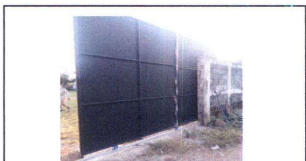
Foto 24: Sustitución de portón
