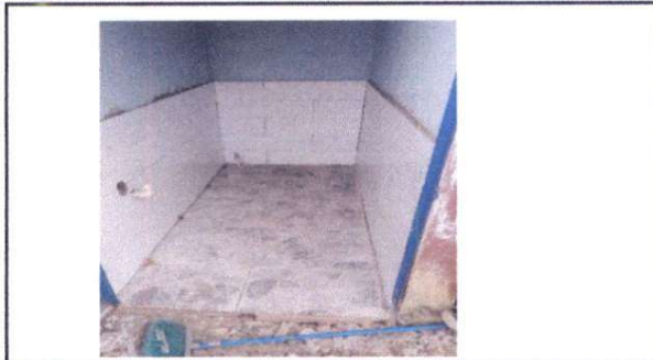
Foto 19: Sustitución de azulejo y reparación de paredes
