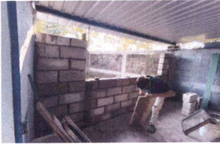
Foto 15: Reparación de pared y columna en cocina
