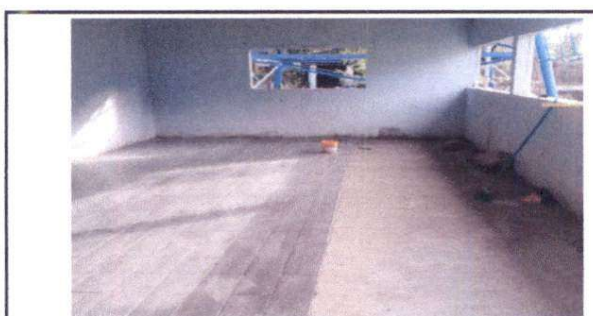
Foto 23: Sustitución de torta de cemento por piso cerámico
