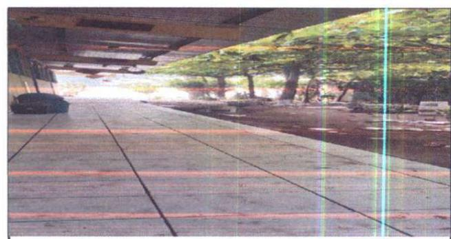
Foto 06: Sustitución de cerámico por torta de cemento en pasillo
