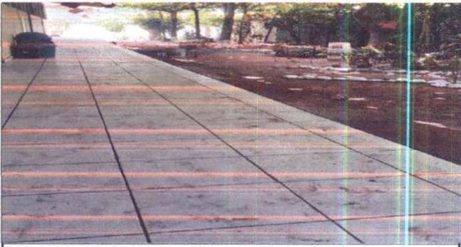
Foto 06. Sustitución de piso cerámico en torta de cemento
