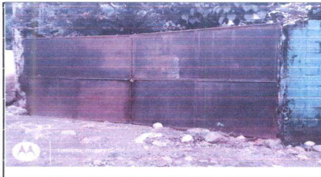
Foto 5: Sustitución de portón de metal
