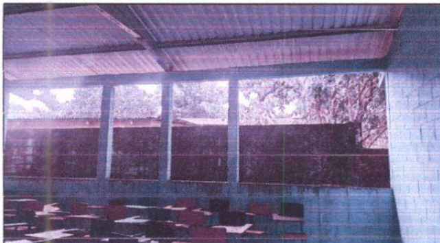
Foto 3: Sustitución de balcones de metal
