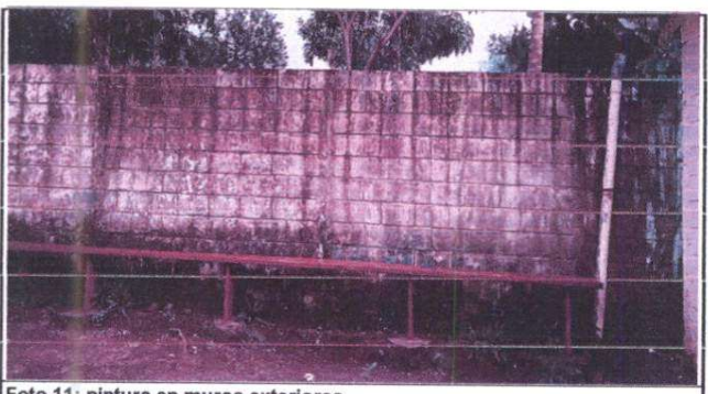
Foto 11: pintura en muros exteriores
