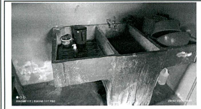
sustitucion de pila ya que se encuentra en mal estaco y filtraciones
