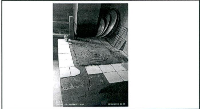
estufa rural en muy mal estado se ara una reparacion completa (sustutucion de plancha y azulejo)
