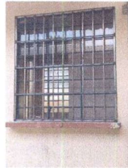
Reforzamiento de ventanas, con balcones externos
