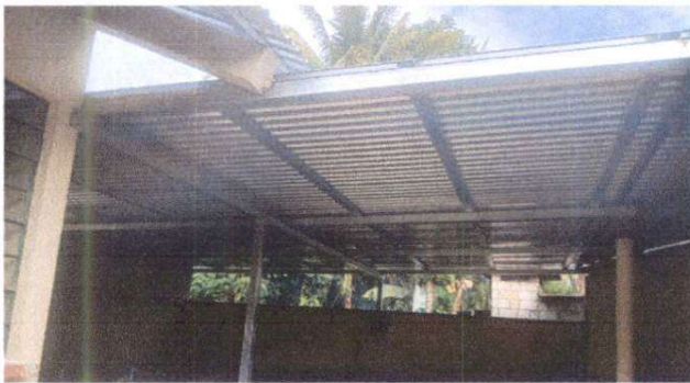
Sustitución de estructura de soporte antigua por costanera galvanizadas
