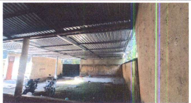
Sustitución de cubierta de lámina por lámina troquelada aluzinc calibre 26 y estructura de soporte de metal en área recreativa
