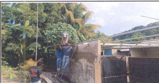
Sustitución de cubierta de lámina y estructura de soporte
