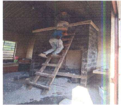
Sustitución de estufa rural por estufa rural completa. (Incluye Chimenea y plancha de metal)
