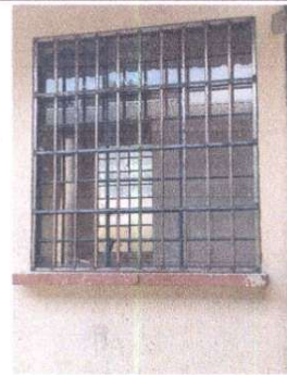
Reforzamiento de ventanas, con balcones externos
