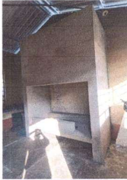
Sustitución de lámina y estructura de soporte de metal en cocina
