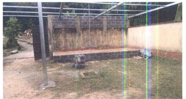
Sustitución de cubierta de lámina por lámina troquelada aluzinc calibre 26 y estructura de soporte de metal en área recreativa
