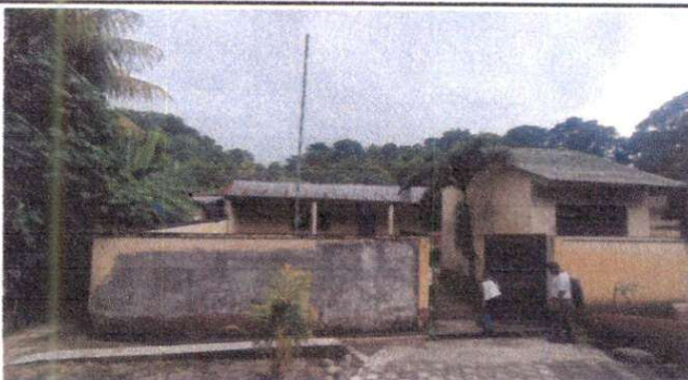
Sustitución de cubierta de lámina y estructura de soporte
