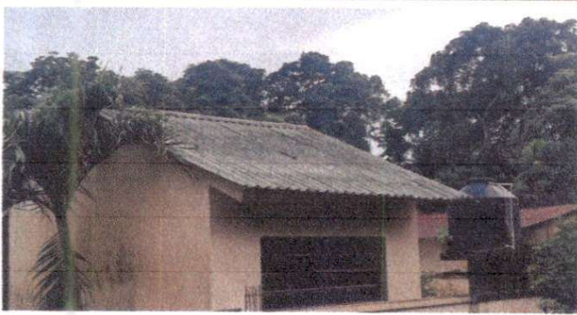
Sustitución de lámina y estructura de soporte de metal en cocina
