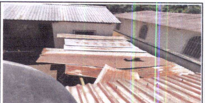
Sustitución de cubierta de lámina por lámina troquelada aluzinc calibre 26 y estructura de soporte de metal en área recreativa
