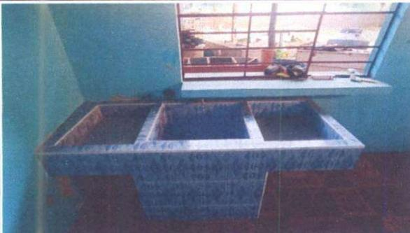
Instalación de pila de concreto fundido, azulejada completa de dos lavaderos
