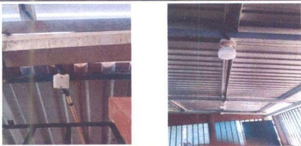
Sustitución de cableado e instalación de focos, interruptores y tomacorrientes
