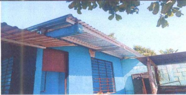
Instalación de estructura de metal y lamina troquelada completo
