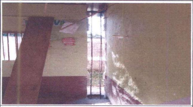
Armado de columna con hierro de 3/8 grado 40 con sus estribos de 1/4
