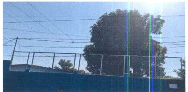
Foto 6. Reparación de tubo hg y mala galvanizada
