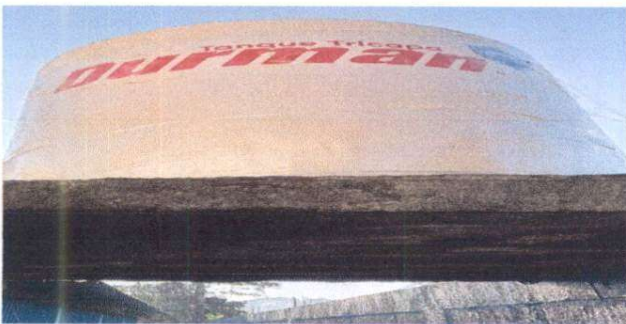
Foto 5. Sustitución de accesorios deposito de agua
