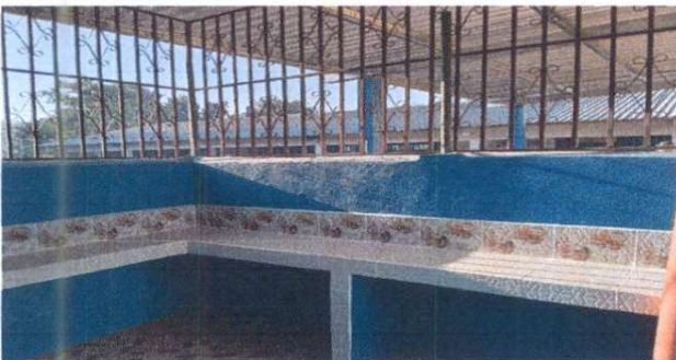
Foto 5. Suministro e instalación de azulejo en mesa de trabajo
