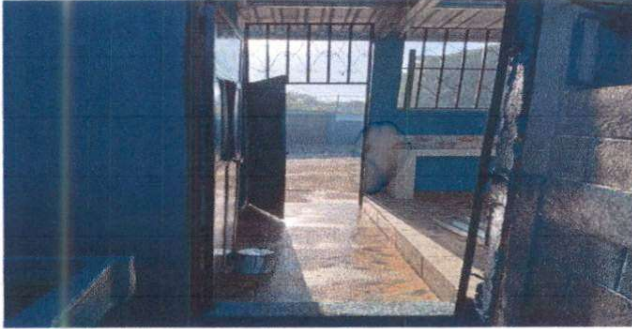
Foto 1. Suministro e instalación de puertas metálicas en cocina
