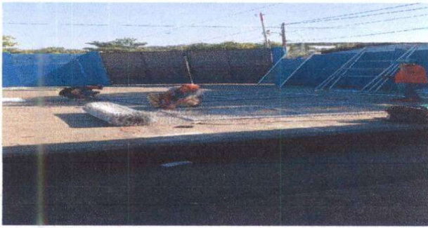
Foto 1. Sustitución de porton de metal corredizo
