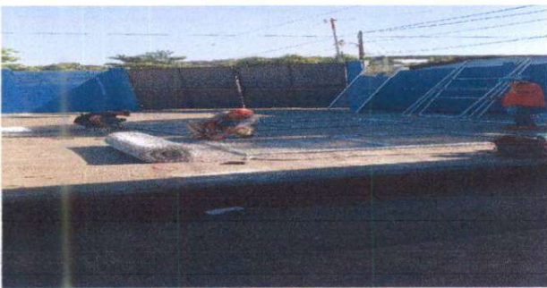
Foto 5. Reparación de muro perimetral
