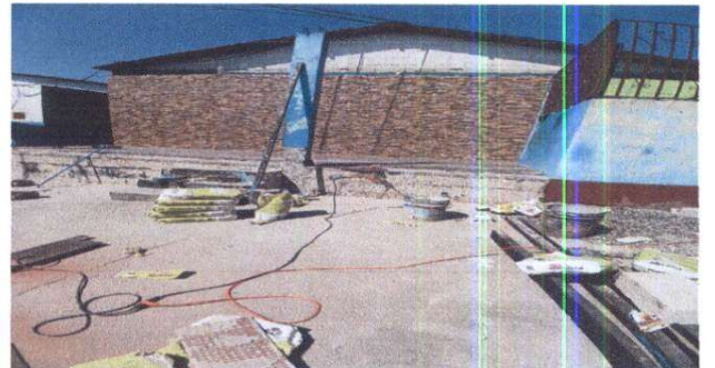
Foto. 4 Sustitución de Azulejo
