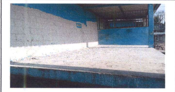
Foto 3. Suministro e instalación de azulejo
