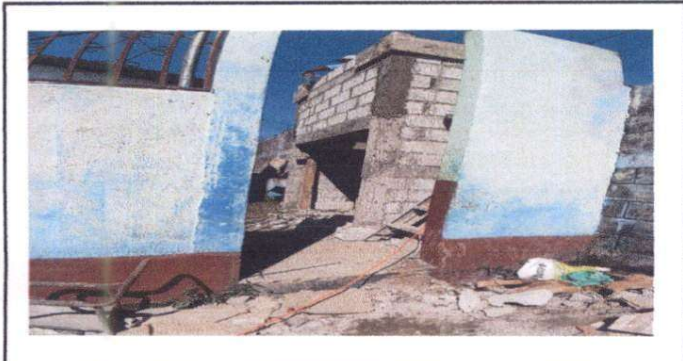
Foto 1. Suministro de puertas metálicas en cocina
