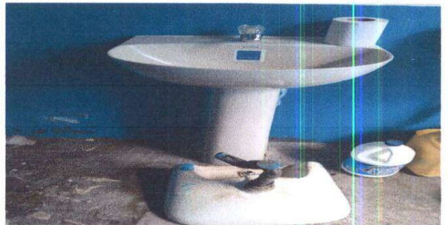
Foto 6. Sustitución de lavamano
