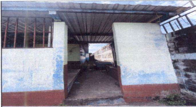
Foto 1. Sumistro e instalación de puertas metálicas en cocina
