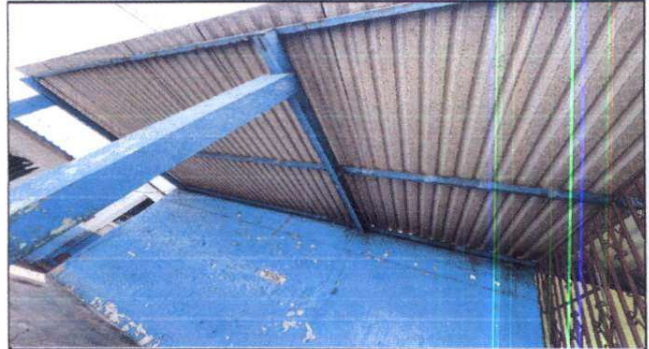
Foto 2. Sustitución de estructura y lámina
