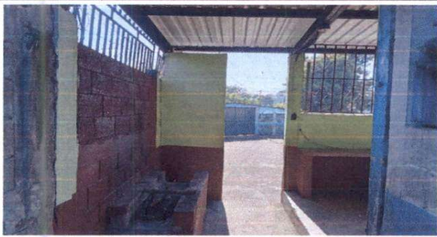
Foto 3: Sustitución de puerta para cocina
