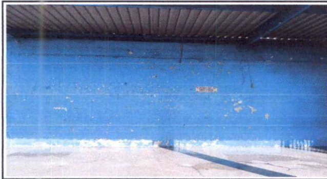
Foto 3. Suministro e instalación de azulejo
