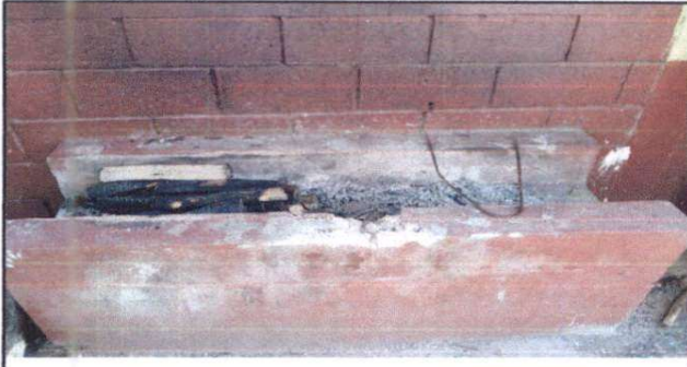
Foto1: Sustitución de estufa rural (completa)
