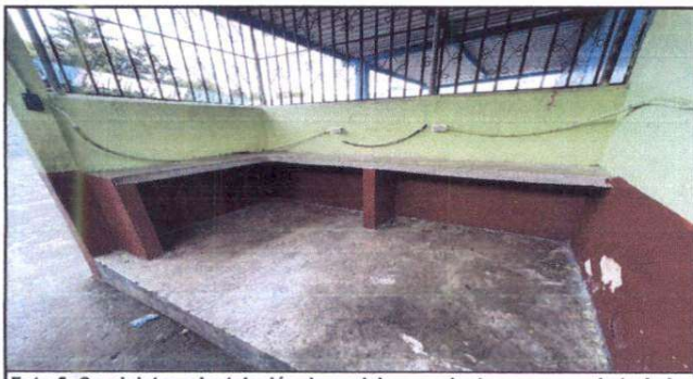
Foto 5: Suministro e instalación de azulejo y gabinetes en mesa de trabajo
