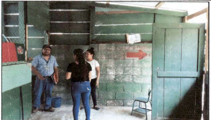
Foto 2: Vista del evaluador realizando la inspección del estado en el que se encuentran las aulas.
