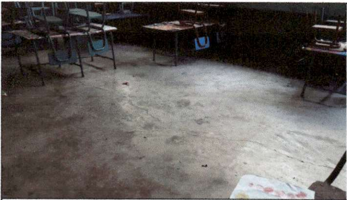
Foto 3: Solicitan trabajos de mejoramiento en aulas, entre ellos la colocación de piso.
