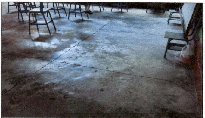
Foto 4: Solicitan trabajos de mejoramiento en aulas, entre ellos la colocación de piso.
