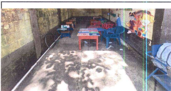
NIVELACION DE TORTA DE CONCRETO E INSTALACION DE PISO CERAMICO
