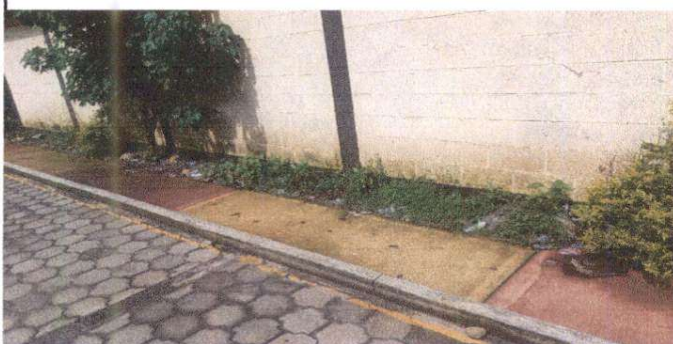
SUMINISTRO DE LOSA PARA EVITAR FILTRACION DE AGUA EN AULAS
