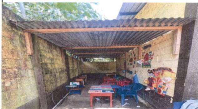
SUMINISTRO DE PARED PARA EVITAR FILTRACION DE AGUA
