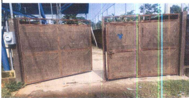
REPARACION DE PORTON, (SUSTITUCION DE VISAGRAS, LIJADO, CEPILLADO Y APLICACIÓN DE 2 CAPAS DE PINTURA ANTICORROSIVA)
