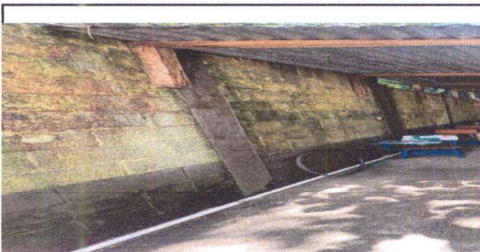
REPELLO EN MUROS E IMPERMEABILIZACIÓN DE PARED EN AULA PARA EVITAR FILTRACION DE AGUA
