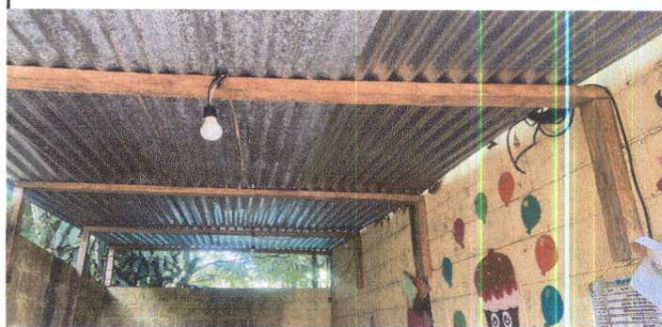
SUSTITUCION DE SISTEMA ELECTRICO Y DE FUERZA
