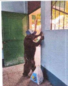
**Foto 8: REPARACIÓN DEL SISTEMA ELÉCTRICO EN AULAS 1,2,3 Y CORREDOR. (Sustitución de tomacorrientes dobles)**
