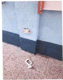
**Foto 7: REPARACIÓN DEL SISTEMA ELÉCTRICO EN AULAS 1,2,3 Y CORREDOR. (Sustitución de tomacorrientes dobles)**
