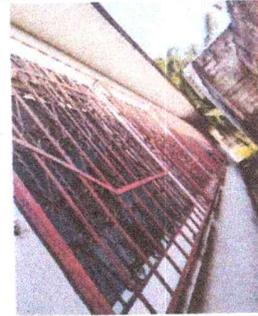
Foto 2: VENTANAS VENTANAS DE AULAS 1,2,3,4, BAÑOS EN HOMBRES Y MUJERES, BODEGA Y DIRECCIÓN (Sustitución de balcones de metal)
