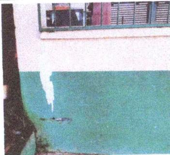
Foto 5: REPARACIÓN DE REPELLO Y CERNIDO DE PAREDES EN CORREDOR, AULAS 1,2,3,4, BODEGA Y DIRECCIÓN
