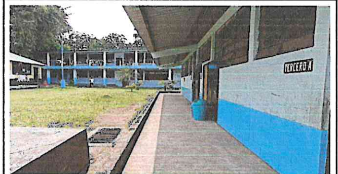
Foto 4: Mantenimiento de pintura en muros exteriores del establecimiento.
