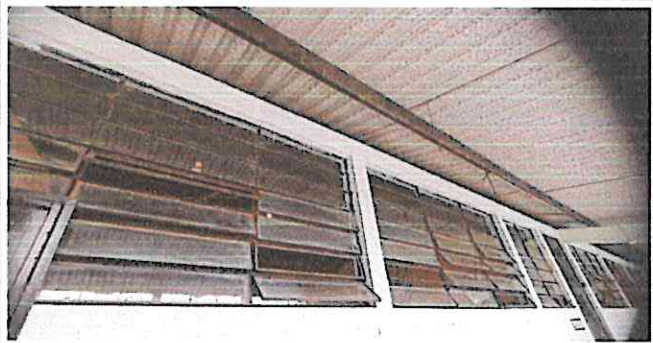
Foto 3: Sustitución de ventanas tipo balcón por balcones de metal en ventanas de aulas.
