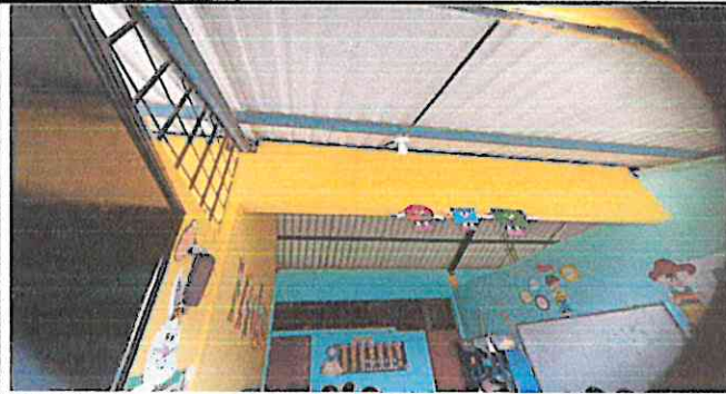
Foto 1: Instalación de cielo falso en 4 aulas del nivel preprimario.
