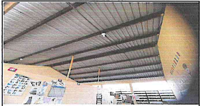
Foto 2: Instalación de cielo falso en 4 aulas del nivel primario.
