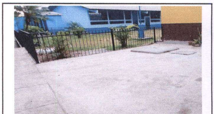
FOTO 16: Módulo 1 Reparacion de plancha de concreto en patio
