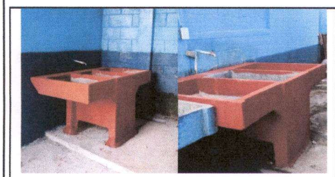
FOTO 17: Módulo 3 Instalación de pila cerca de los baños.
