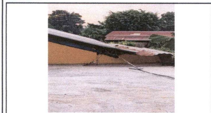
FOTO 15: Módulo 1 Reparación de cableado eléctrico en Dirección.
