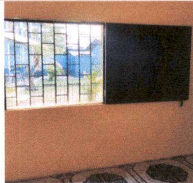
FOTO 4: Módulo 1 Mantenimiento a estructura metal de ventana en Dirección
