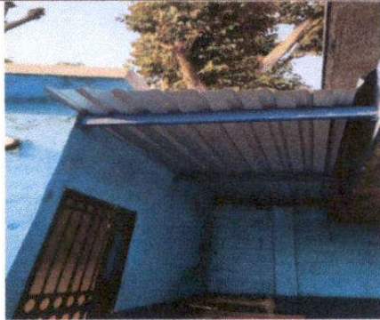
FOTO 1: Módulo 1 Cambio cubierta de láminas en Dirección
