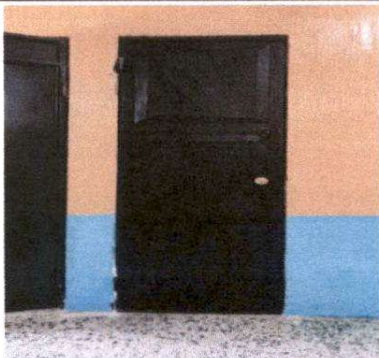
FOTO 3: Módulo 3 Mantenimiento a estructura metal de puertas en Bodega
