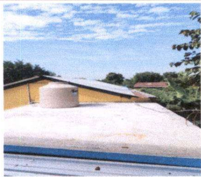
FOTO 2: Módulo 1 Impermeabilización de losa en Dirección
