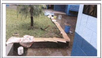
FOTO 9:Modulo 3 Patío sustitución de tuberia PVC linea principal de aguas pluviales
