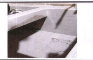
FOTO 8: Módulo 3 COCINA: Sustitución de azulejo en pila
