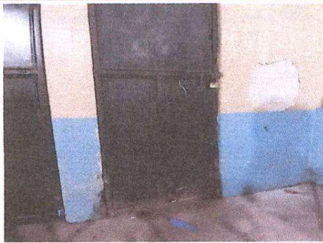
FOTO 3: Módulo 3 Mantenimiento a estructura metal de puertas en Bodega
