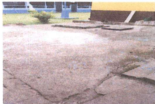
FOTO 16: Módulo 1 Reparación de plancha de concreto en patio
