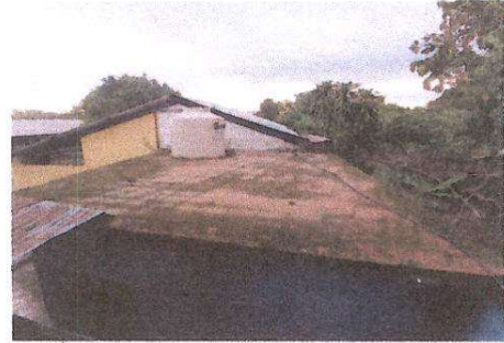
FOTO 2: Módulo 1 Impermeabilización de losa en Dirección
