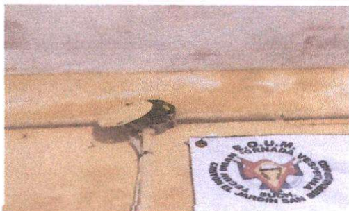
FOTO 11: Módulo 1 Direcciòn reparaciòn de sistema elèctrico
