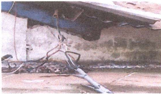
FOTO 15: Módulo 1 Reparación de cableado eléctrico en Dirección.
