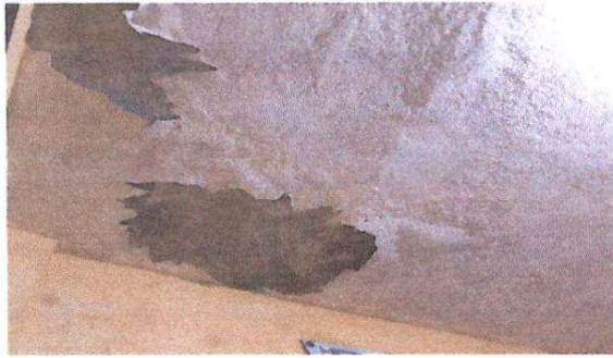
FOTO 13: Módulo 3 Cocina reparación de repello y cernido de paredes en cocina
