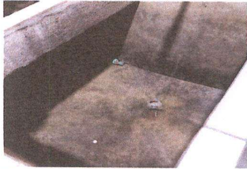
FOTO 8: Módulo 3 COCINA: Sustritiòn de azulejo en pila
