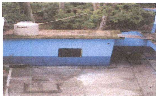
FOTO 10: Módulo 1 Patio reparaciòn de planchas de concreto de patio
