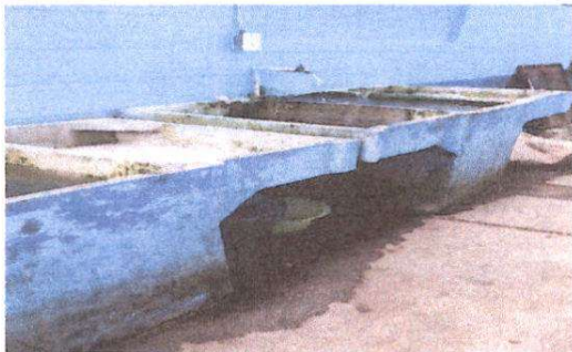
FOTO 17: Módulo 3 Instalación de pila cerca de los baños.
