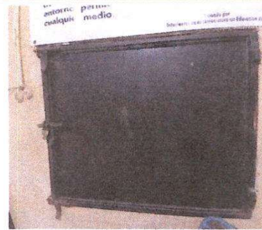
FOTO 4: Módulo 1 Mantenimiento a estructura metal de ventana en Dirección
