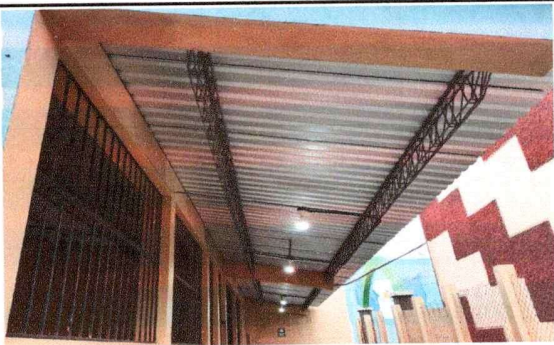
FOTO 5: Módulo de aulas 3 y 4: Reparación del Sistema Eléctrico
