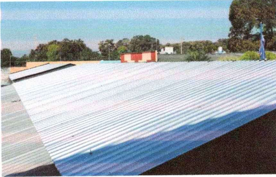
FOTO 1: Módulo de aulas 3 y 4: Cambio de cubierta de láminas.
