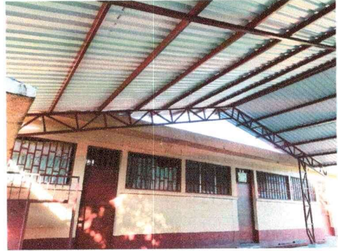
FOTO 2: Módulo de aulas 6: Sustitución de elementos de fijación.
