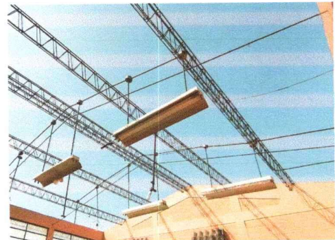
FOTO 4: Módulo de aulas 3 y 4 : Mantenimiento a estructura de soporte de metal
