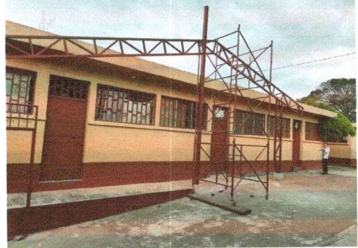
FOTO 2: Módulo de aulas 6: Sustitución de elementos de fijación.
