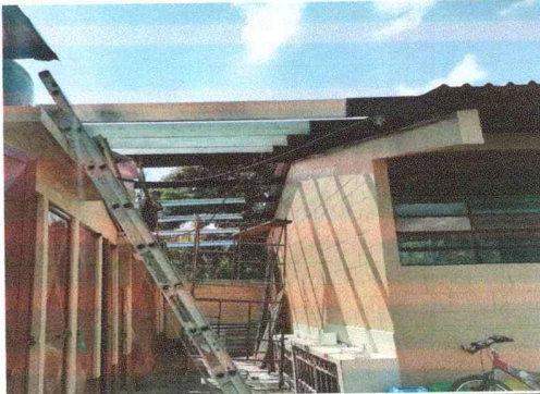
FOTO 3: Módulo de lavamanos: Sustitución de elementos de fijación
