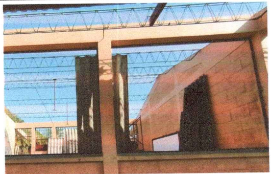
FOTO 6: Módulos de aulas 3 y 4: Sustitución de estructura de metal a ventana
